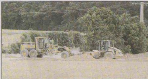
ACCÈS. De nombreux engins de terrassement, nivellement et compactage sont sur site pour les réaliser.
