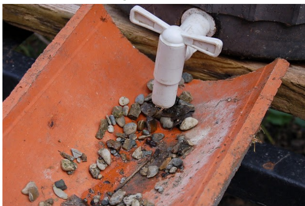
Goutte à goutte avec cailloux
